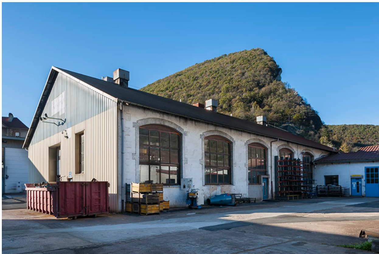
Atelier de forge, depuis la cour.
