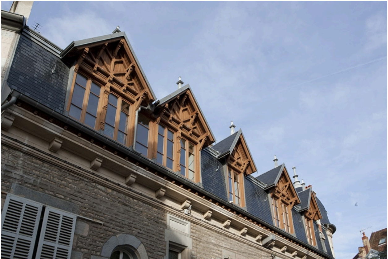
Toiture : détail des lucarnes donnant rue Luc Breton.
