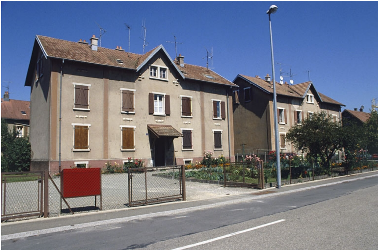
Logements collectifs ouvriers rue Georges Dollfus.
