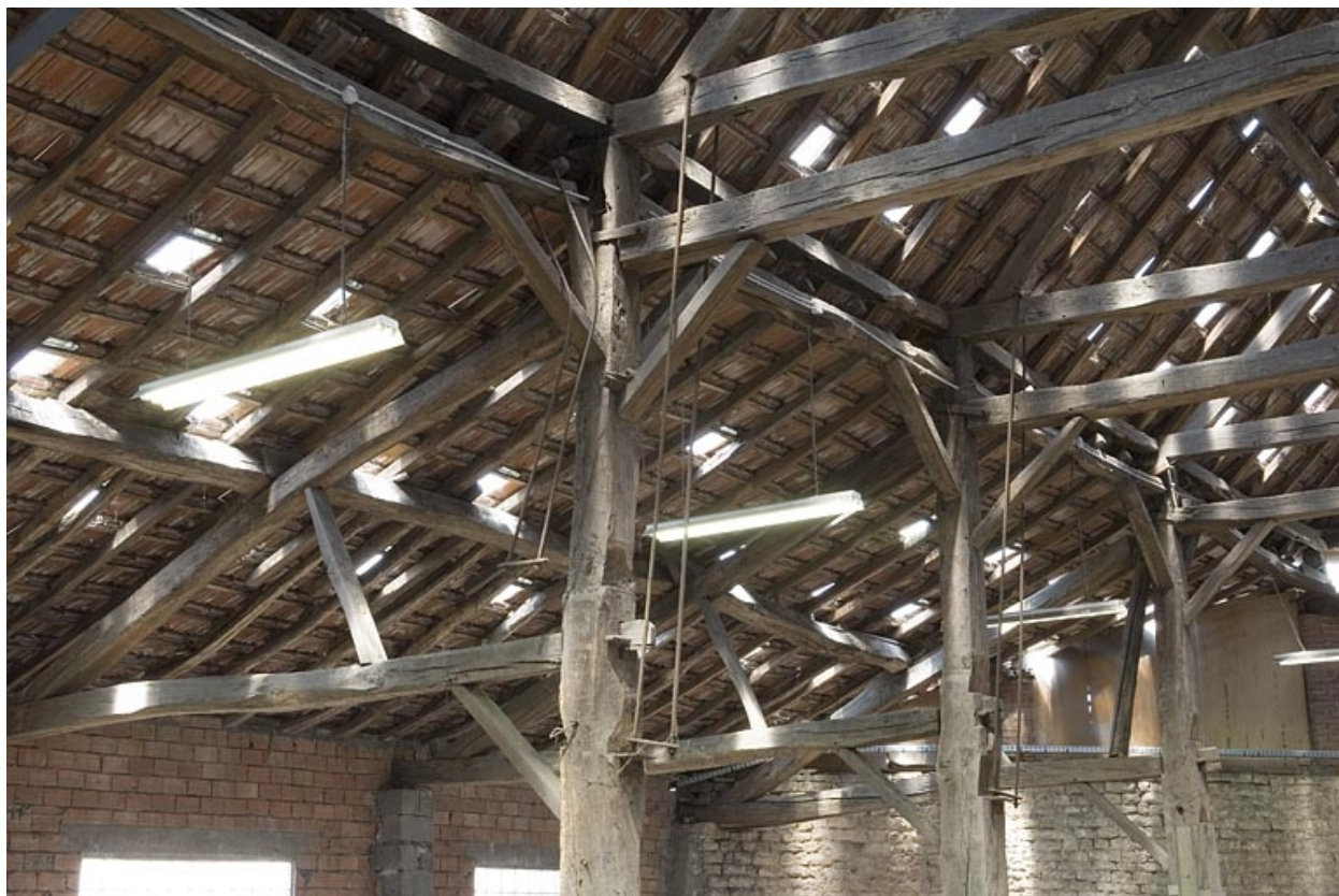
Magasin industriel. Détail de la charpente.
