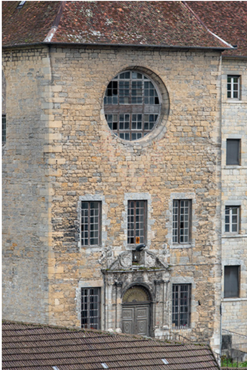
Façade ouest de la chapelle, depuis le nord-est.
