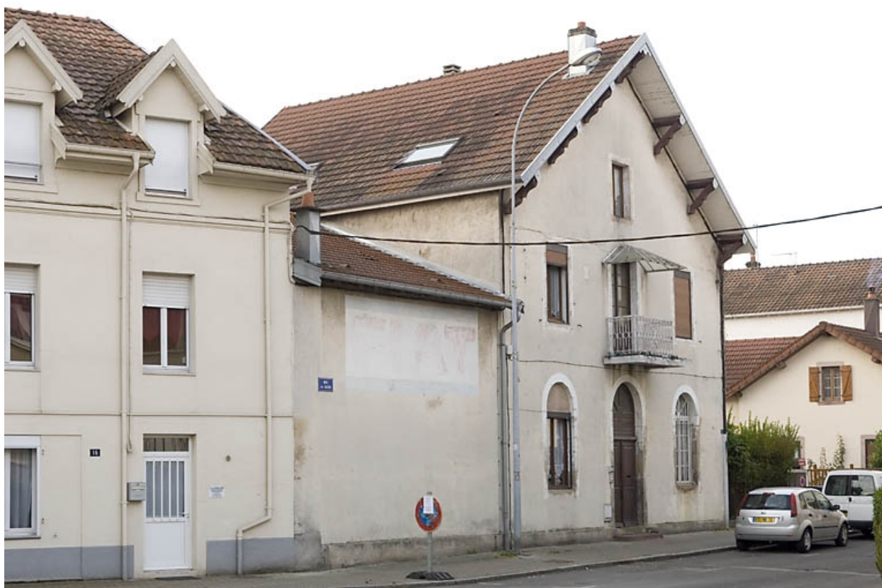
Logement patronal. Vue de trois quarts.
