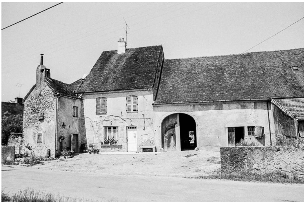
Ferme située rue d'Oisenans : façade antérieure.
