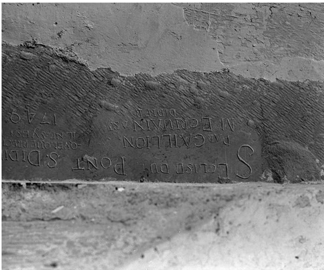
Fenêtre gauche de l'abside, graffitis de l'appui.
