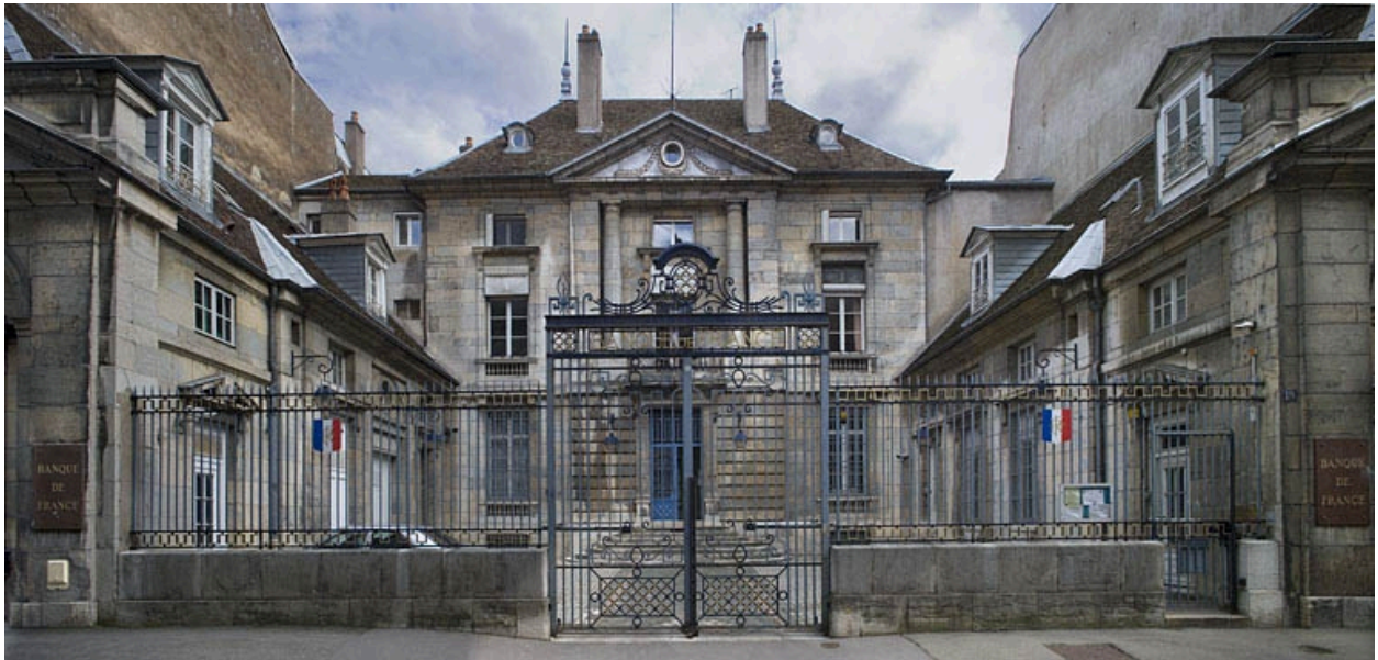
Vue d'ensemble de face depuis la rue.
