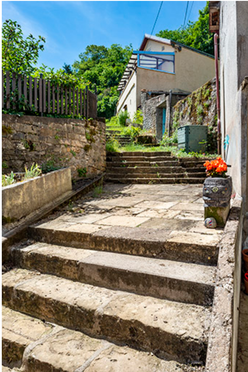
Escalier isolé au n° 51.
