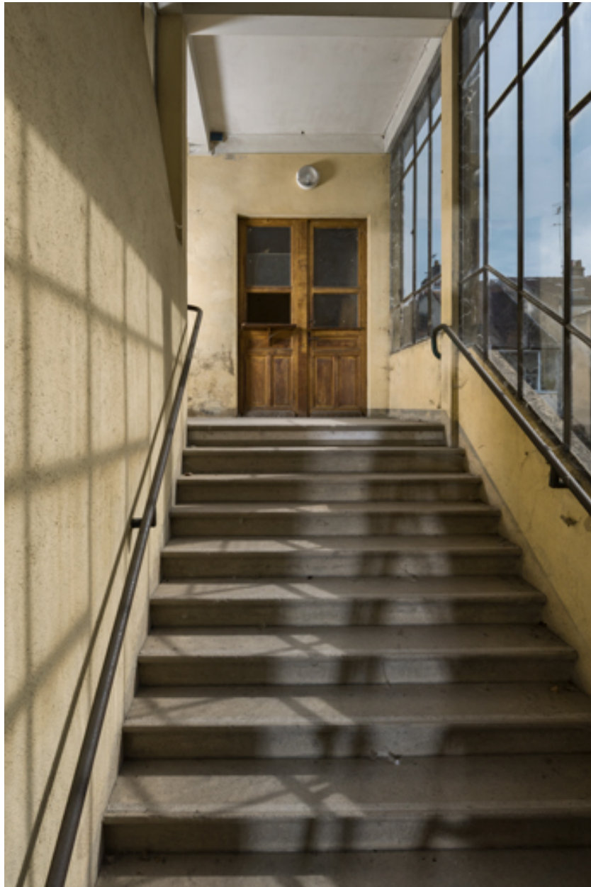
Escalier principal : première volée et guichet sur le repos.
