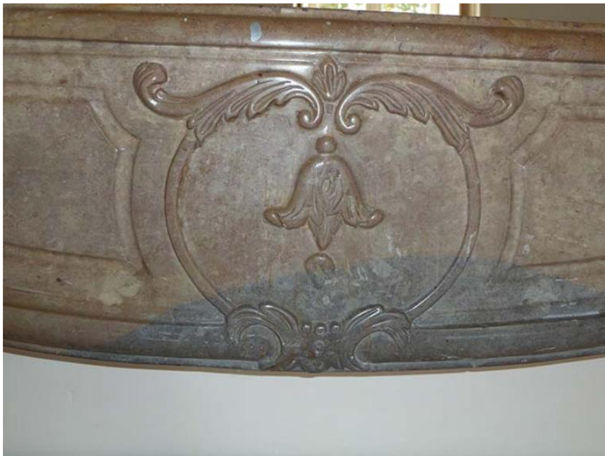
Cheminée en marbre de l'étage, détail
