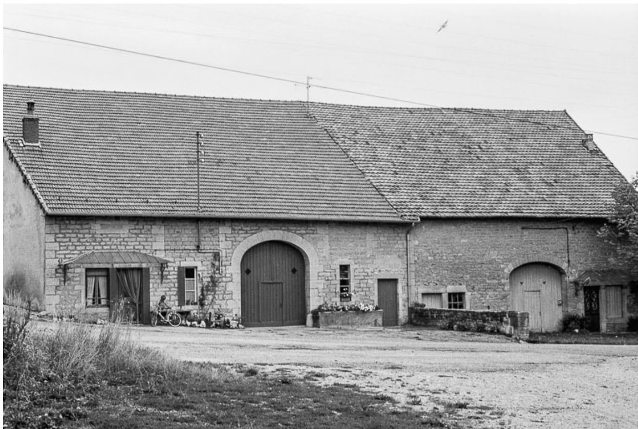
Fermes cadastrées B2 181 et 182 : façades antérieures.
