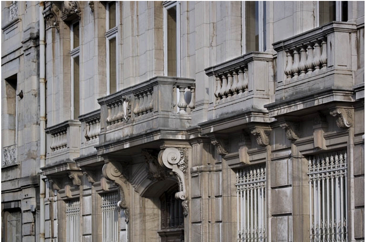
Détail des garde-corps et du balcon du premier étage sur rue.
