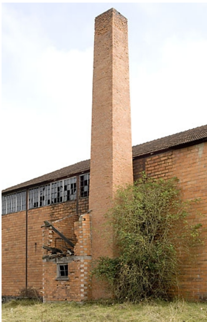
Cheminée et atelier de fabrication.
