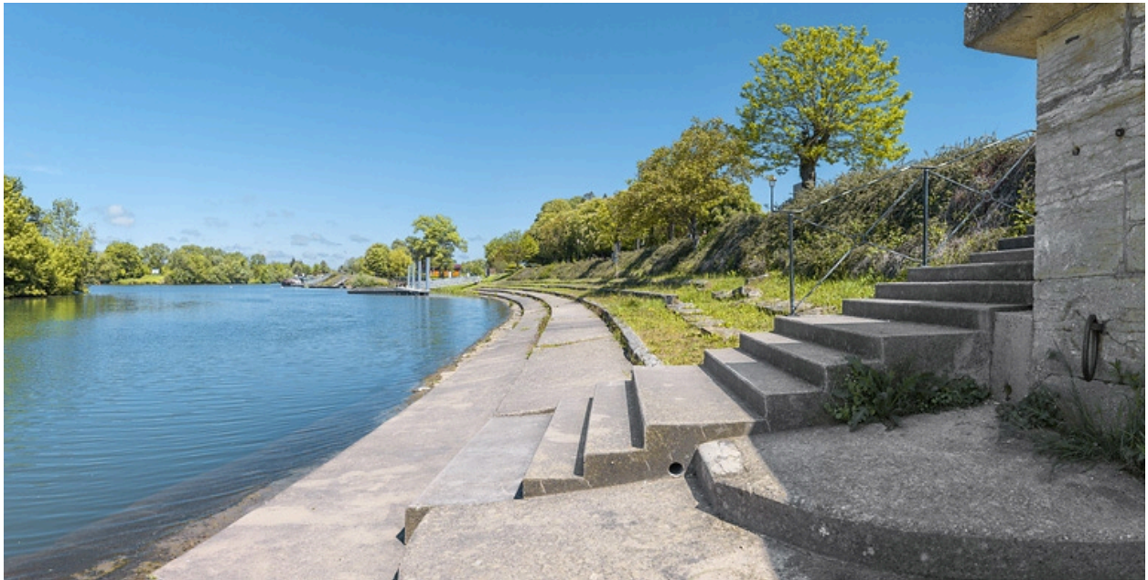
Vue rapprochée des quais à gradins avant leur restauration.
