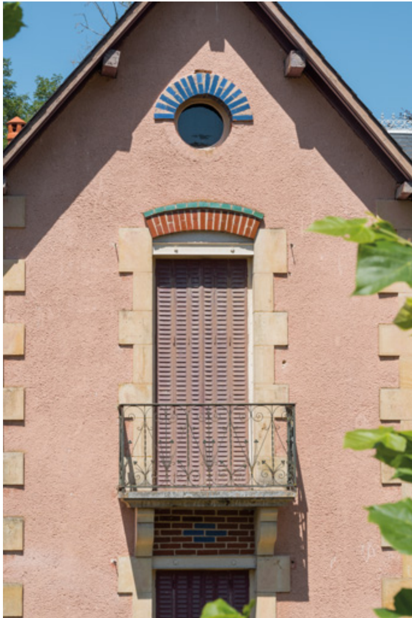
Mur-pignon, détail des ouvertures, vue de face.
