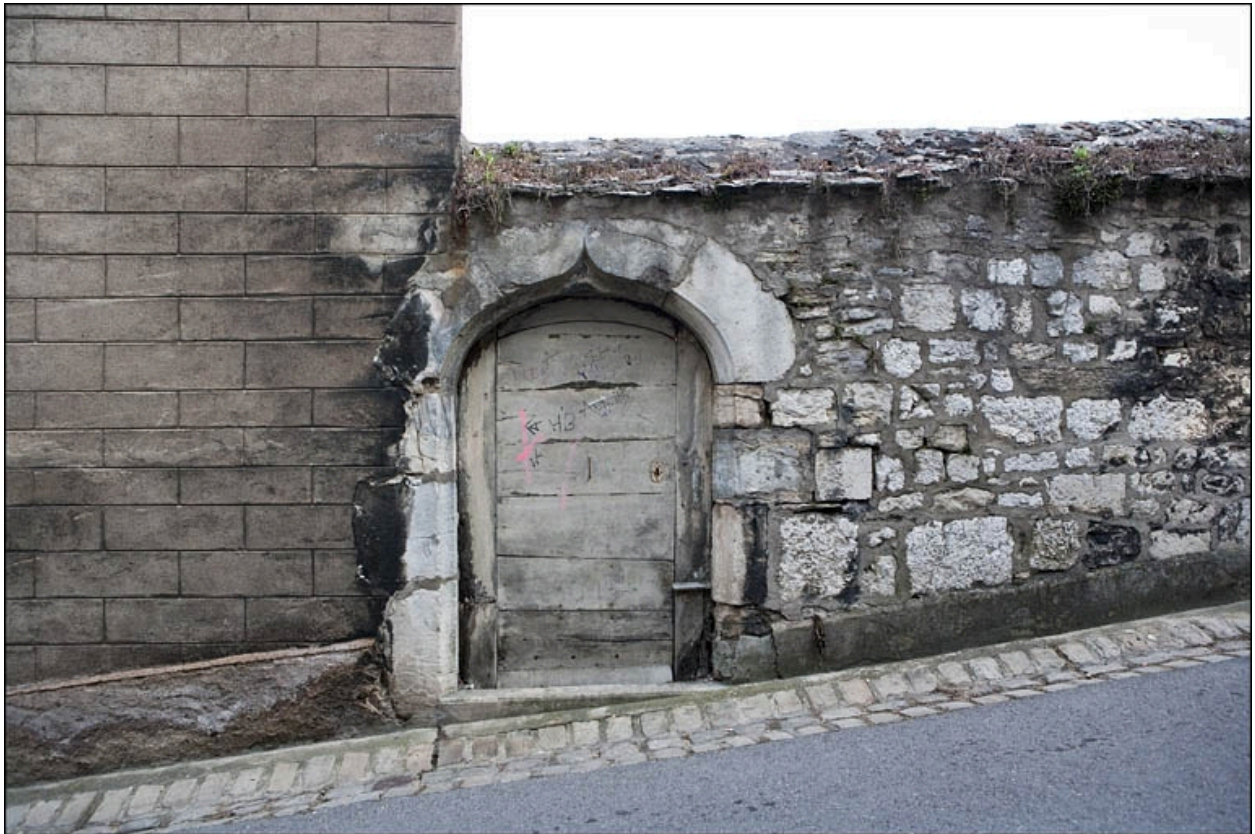
Détail de la porte dans la clôture de jardin.
