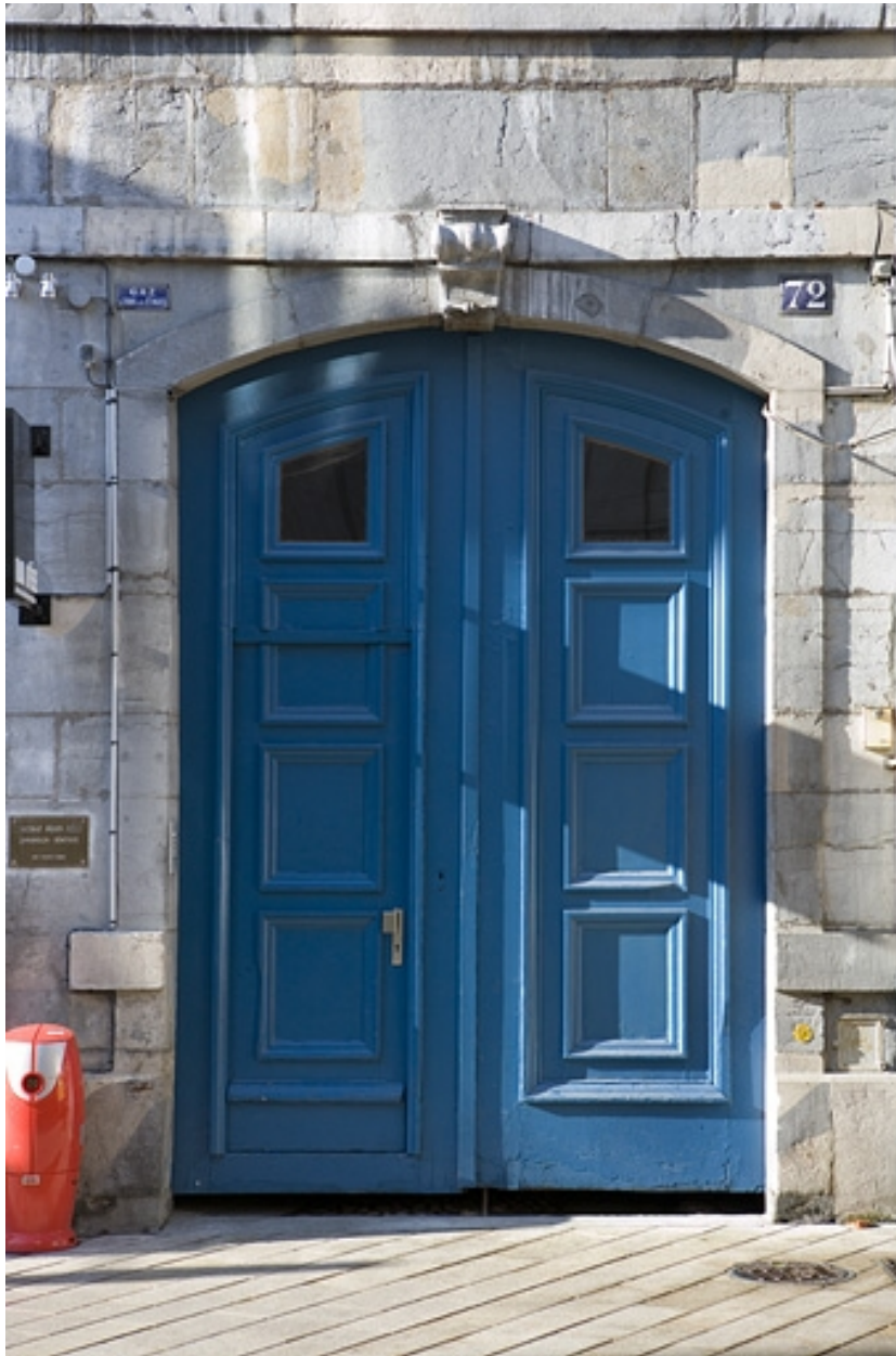
Détail du portail d'entrée.
