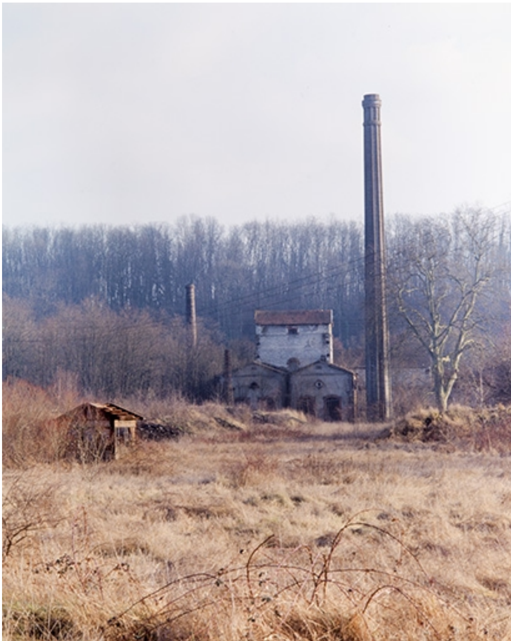
Forge Neuve. Centrale électrique, monte-charge du haut-fourneau et cheminée vus du nord-ouest.
