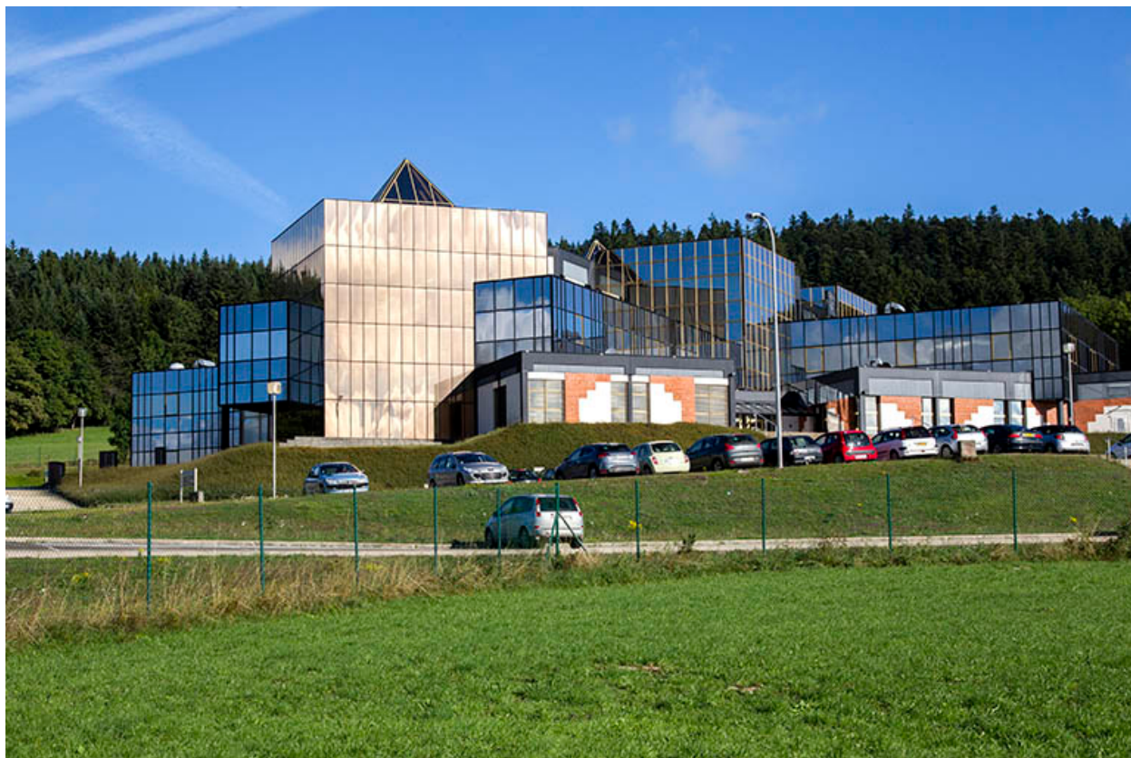
Vue d'ensemble rapprochée, depuis le sud.
