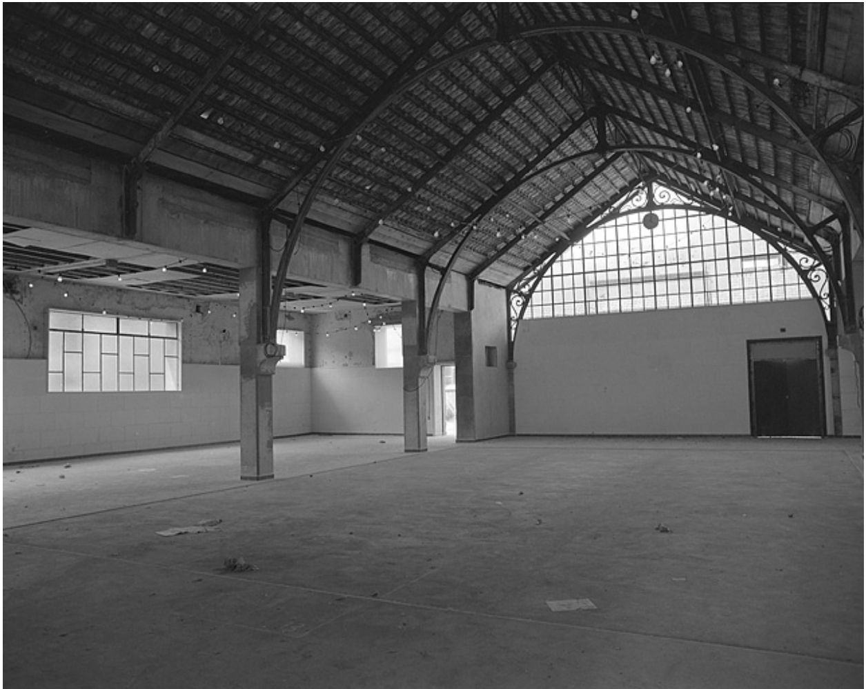
Vue intérieure de la halle.
