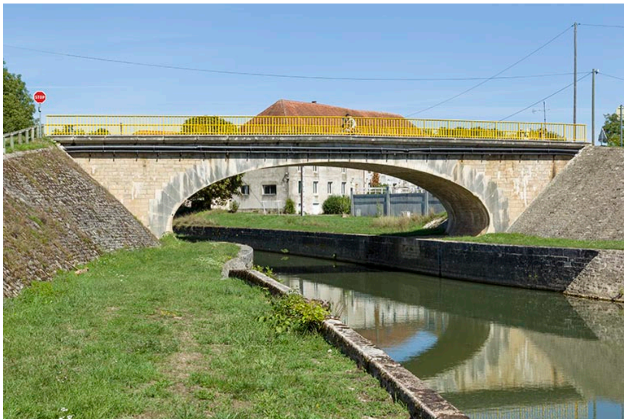
Pont de la dérivation de Soing (70).
