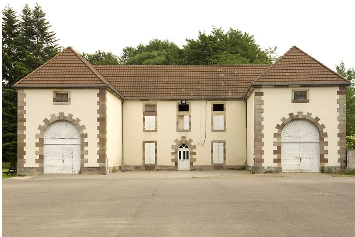
Ecuries et remises. Vue de face.
