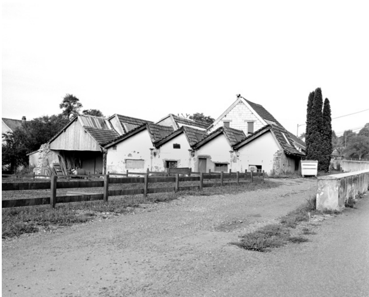
Extrémité orientale de l'atelier de fabrication.
