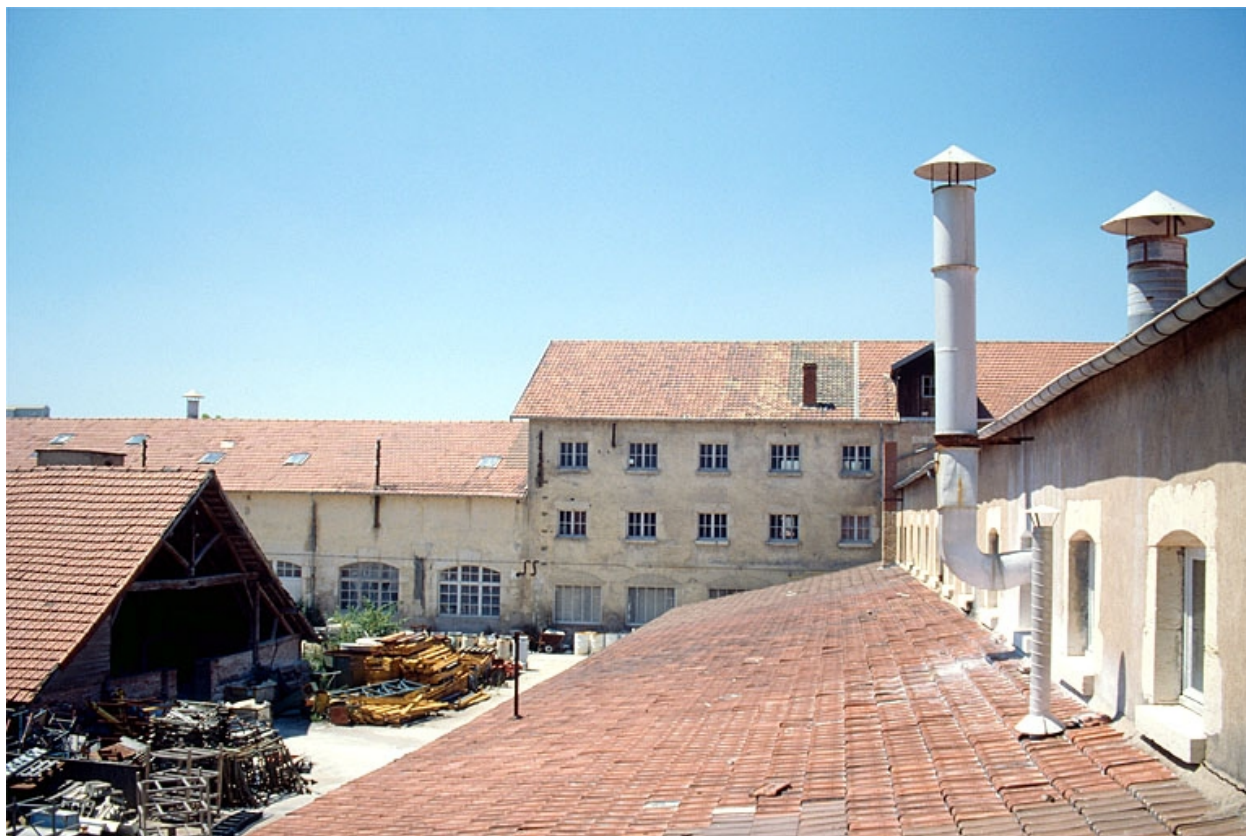
Vue partielle de l'atelier (27), depuis l'est.
