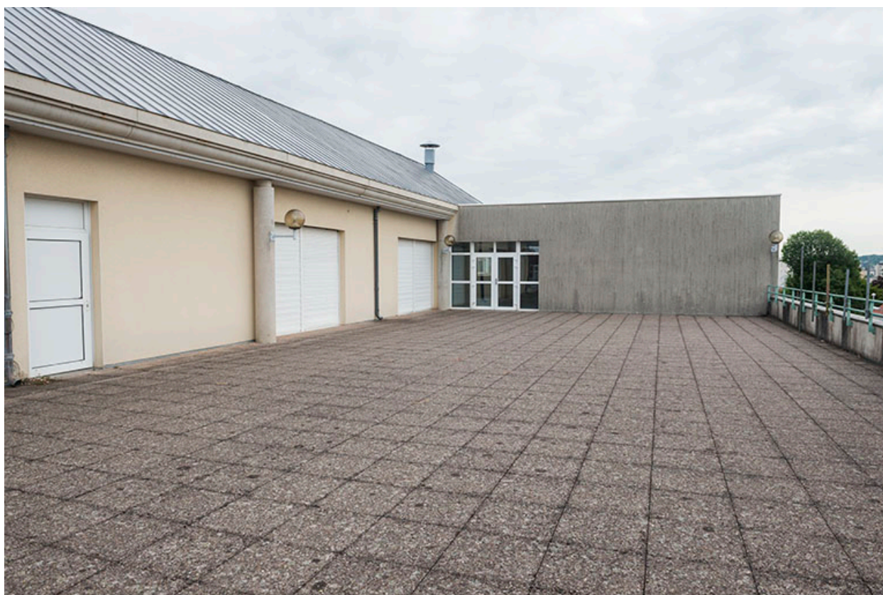
Terrasse du bâtiment de l'angle sud-est (atelier, administration).
