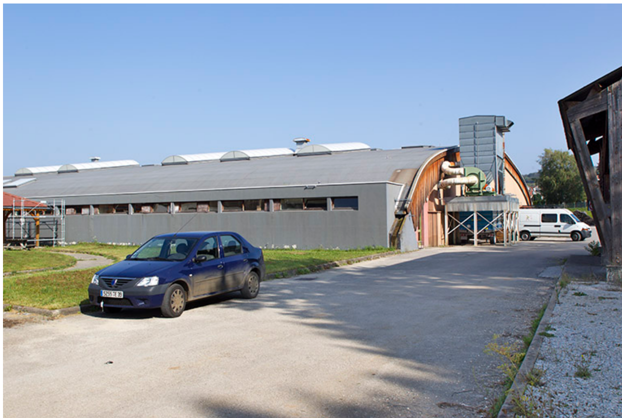
Atelier : façade nord.
