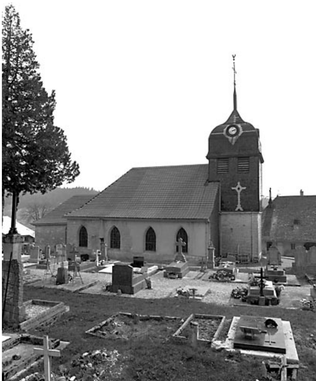
Vue de la façade latérale nord.
