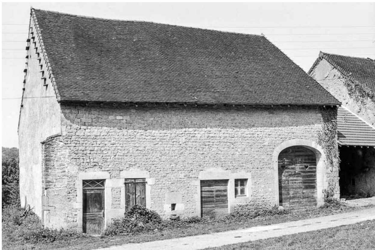
Ferme cadastrée ZK 35 : façade antérieure.
