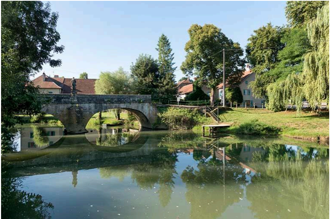
Vue du pont côté Nord
