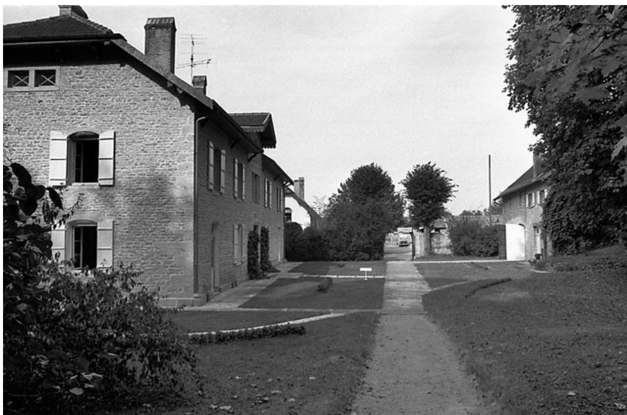
Façades sur cour.
