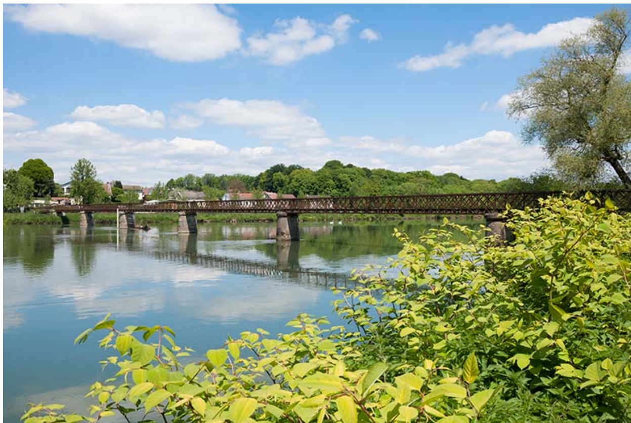
La passerelle vue depuis la rive gauche.
