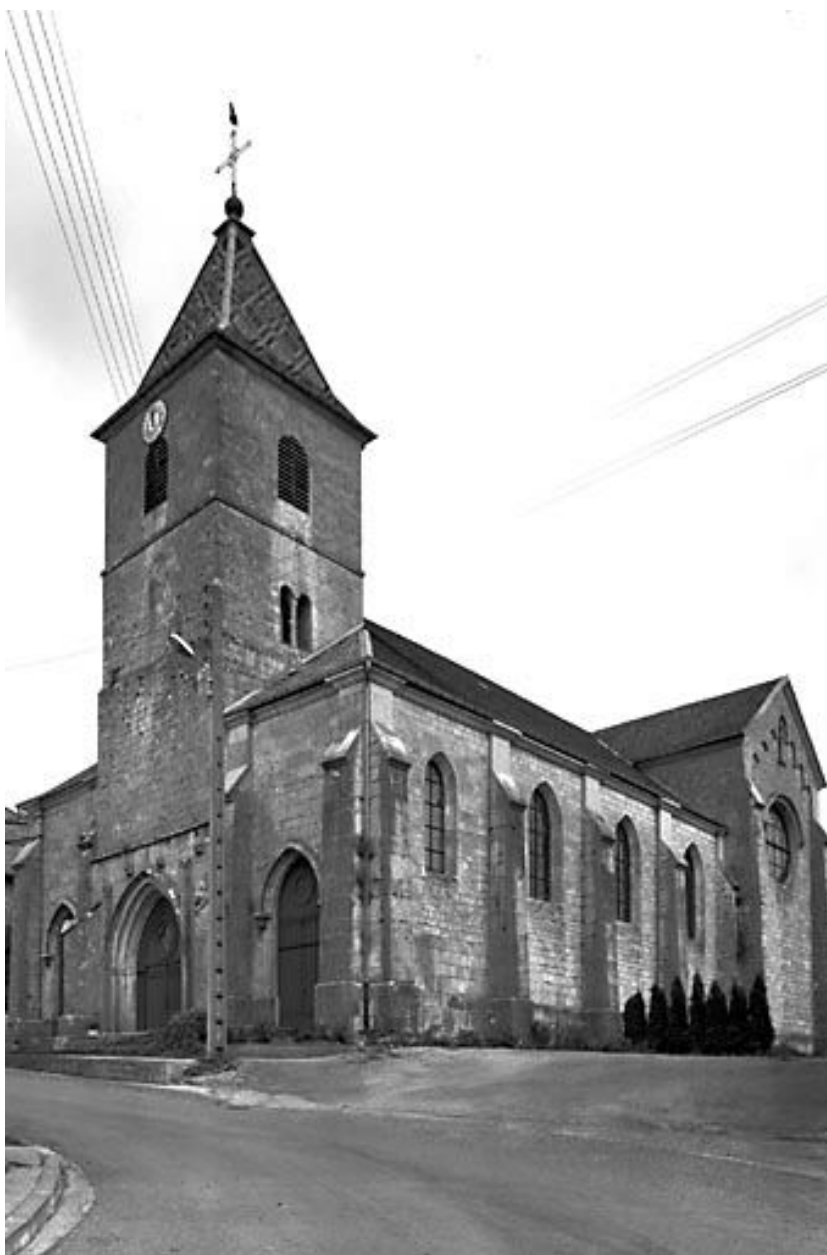
Façade antérieure et face latérale droite.
