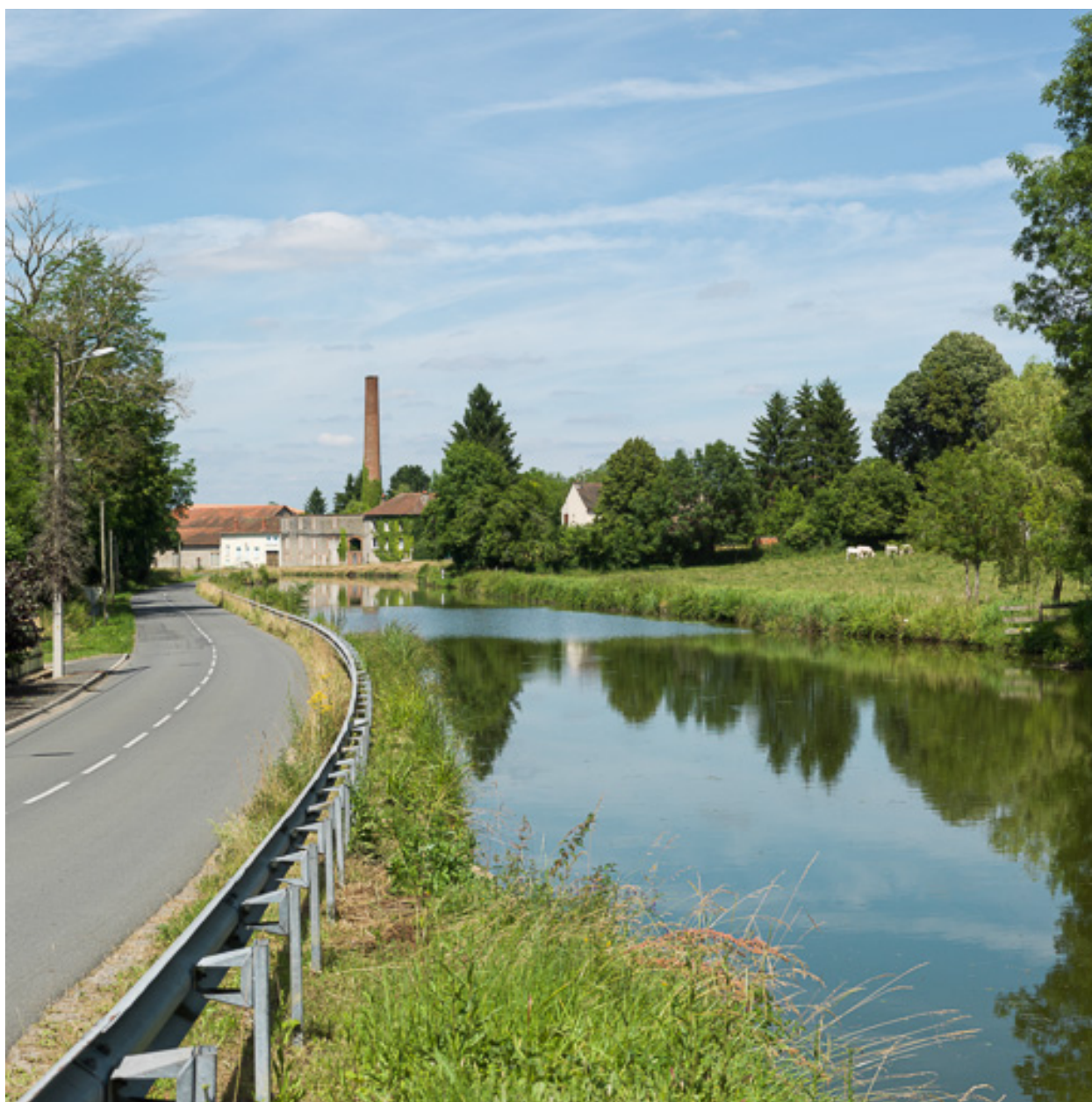
Vue d'ensemble d'aval.
