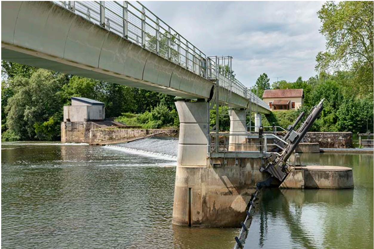
Vue de détail sur les clapets.
