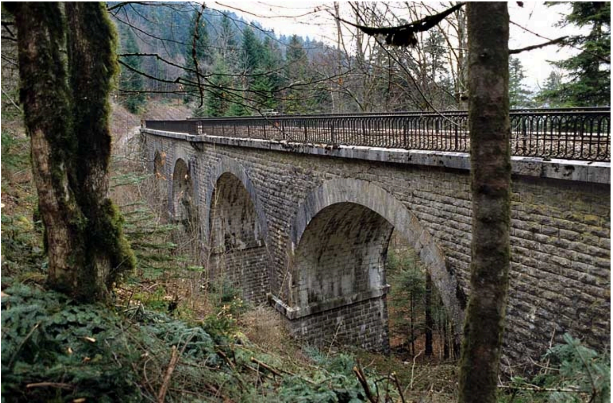
Viaduc : élévation sud (côté rocher).
