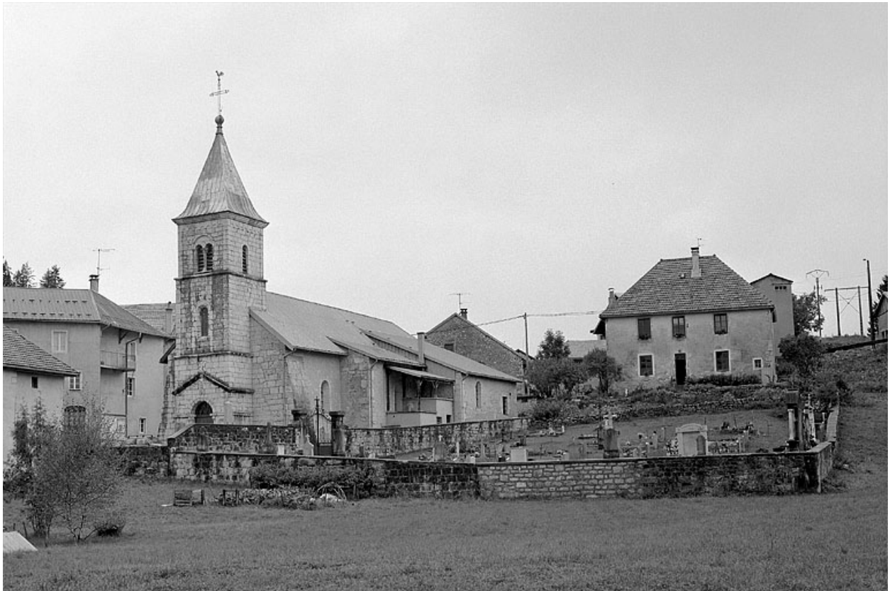
Extérieur : vue générale depuis le sud-ouest.
