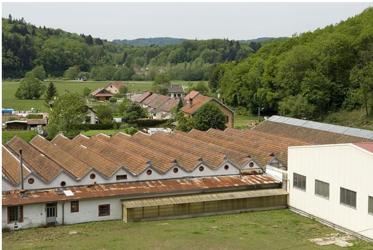
Vue plongeante depuis l'est. Extrémité nord.
