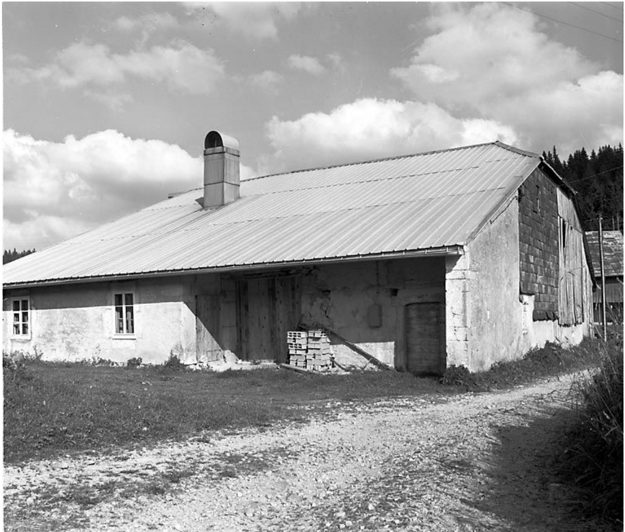
Façades postérieure et latérale gauche.
