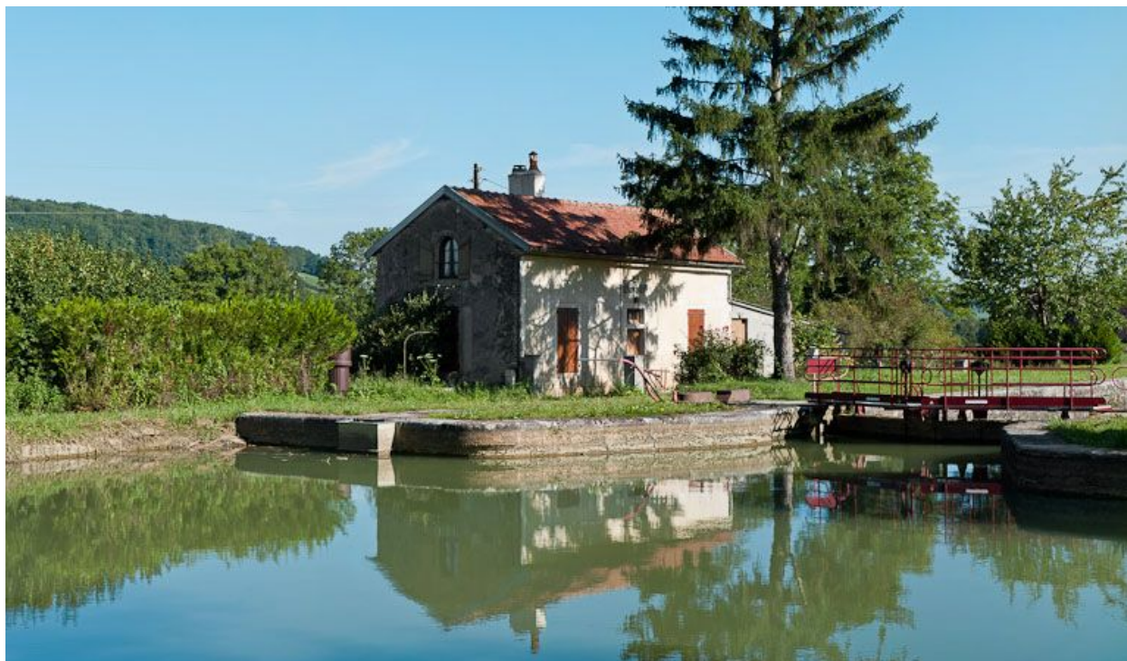
Vue du site d'écluse depuis l'amont.
