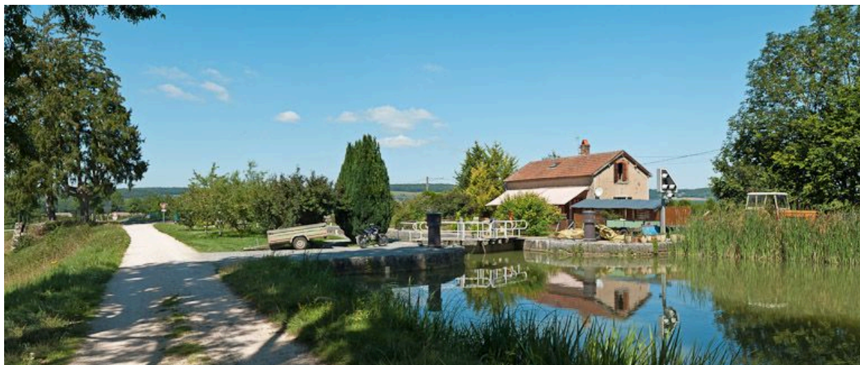
Vue d'ensemble du site d'écluse.
