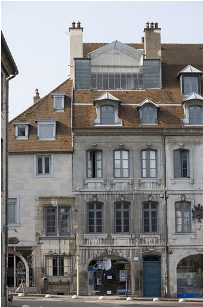
Partie gauche de la façade sur rue, de face.
