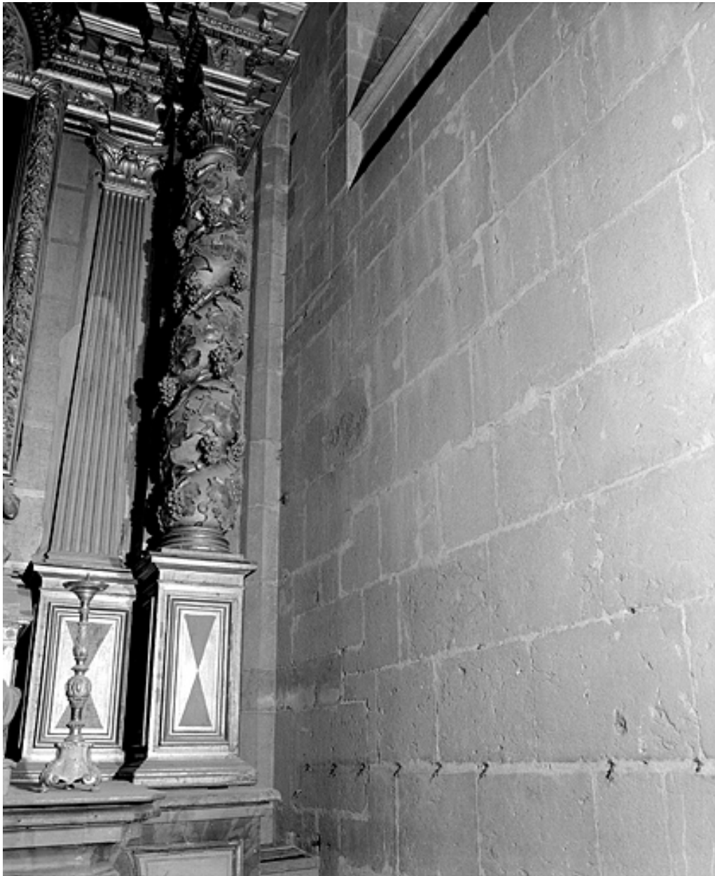
Détail du parement du collatéral sud : couture à hauteur de la huitième travée.
