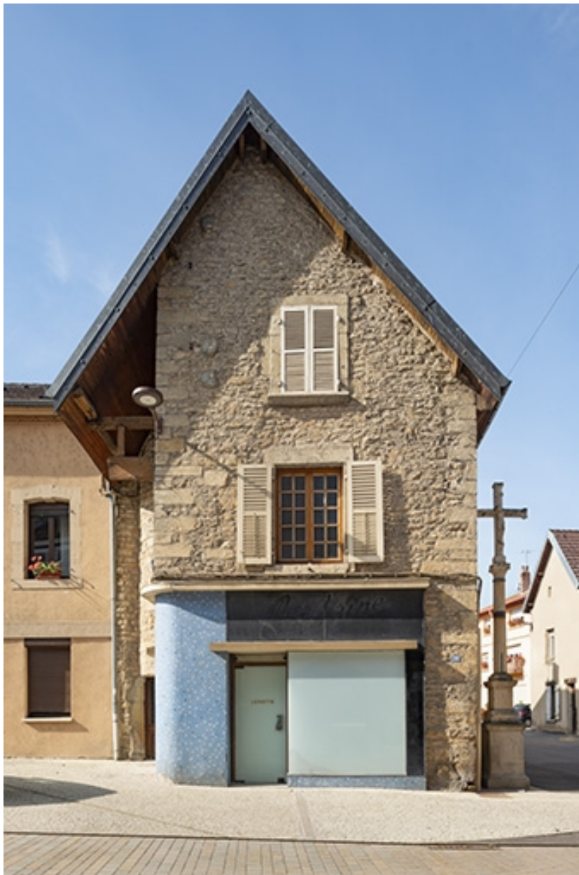
Le pignon depuis la rue Gambetta.
