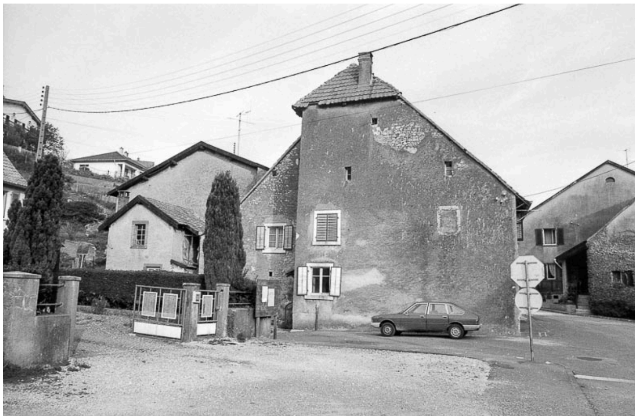
Façade latérale gauche.
