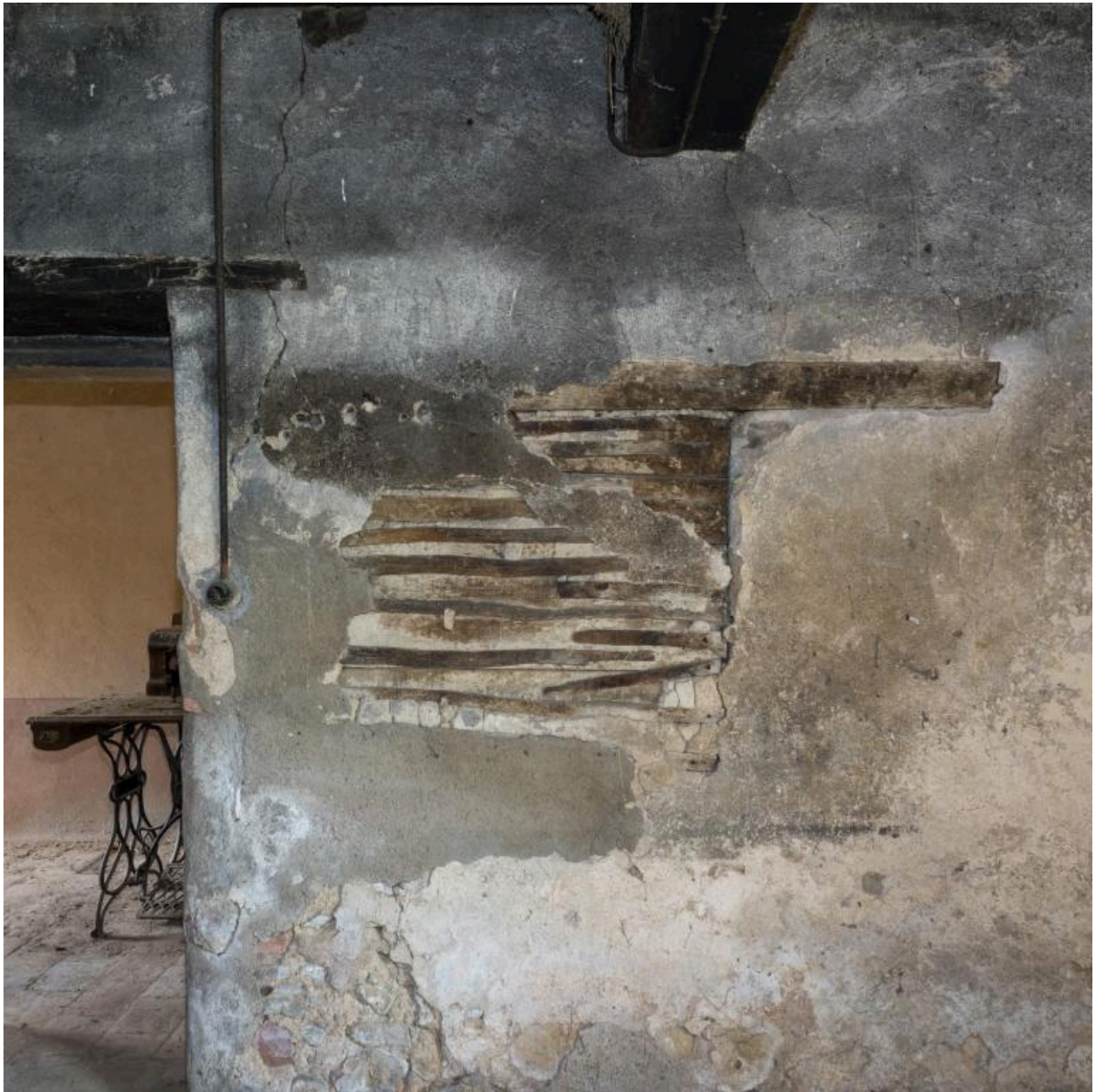
Détail de la cloison de la cuisine (ancienne chambre) de la maison Mommessin
