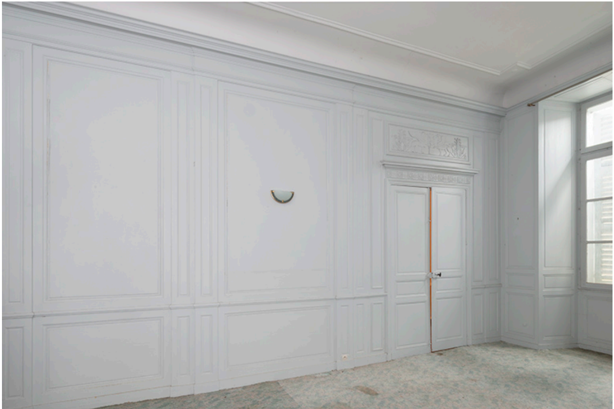
Aile nord. Boiseries d'une pièce du premier étage.
