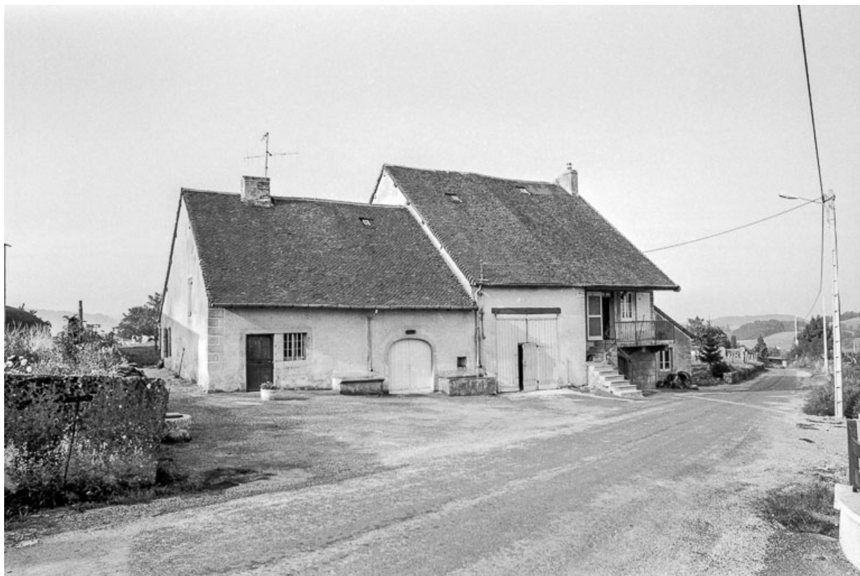
Ferme située à Pannessières.
