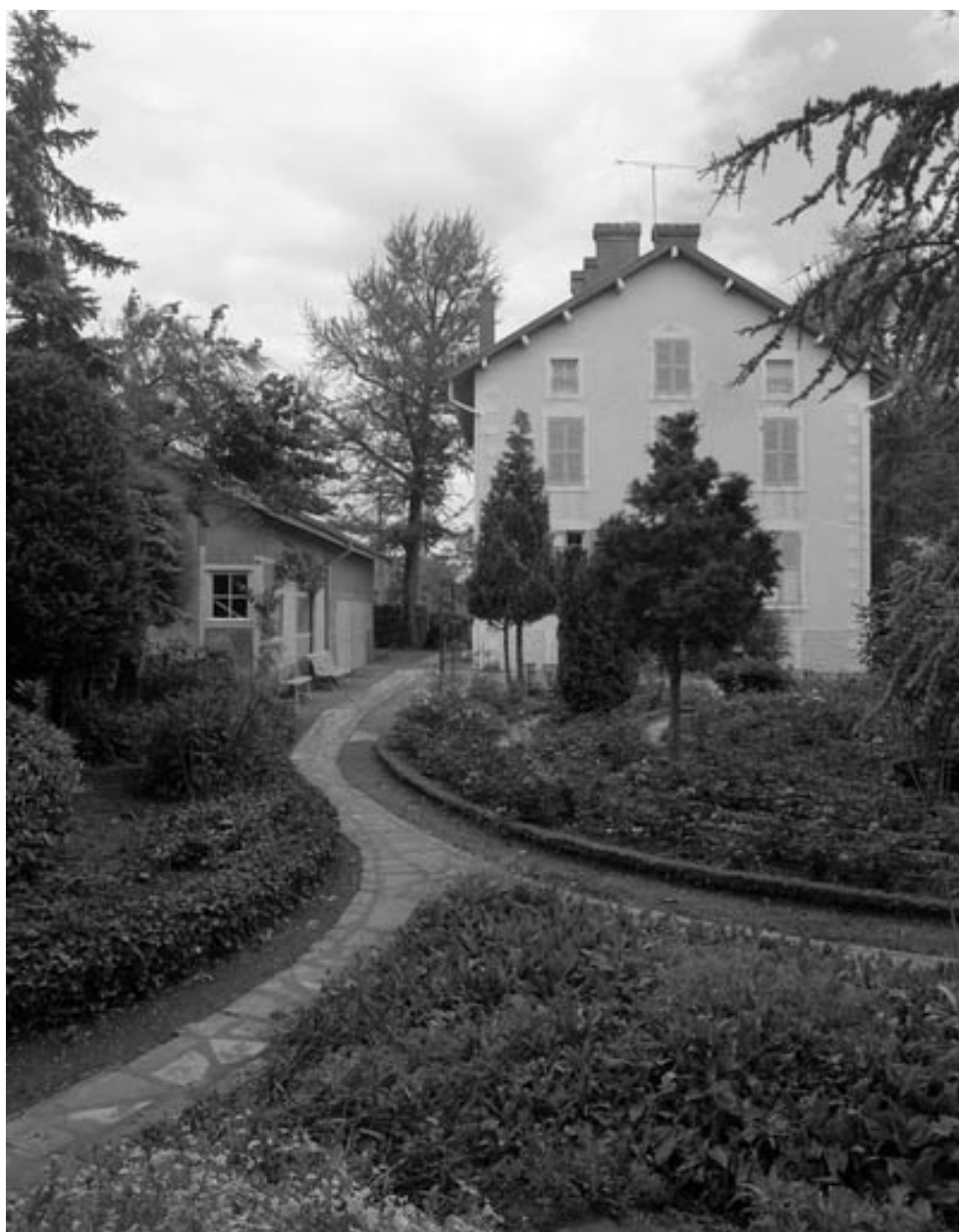
Vue de la façade postérieure.
